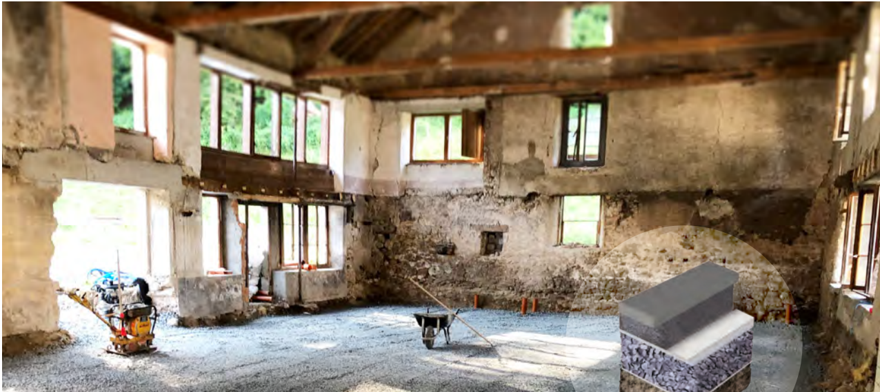
Sanierung mit MISAPOR
