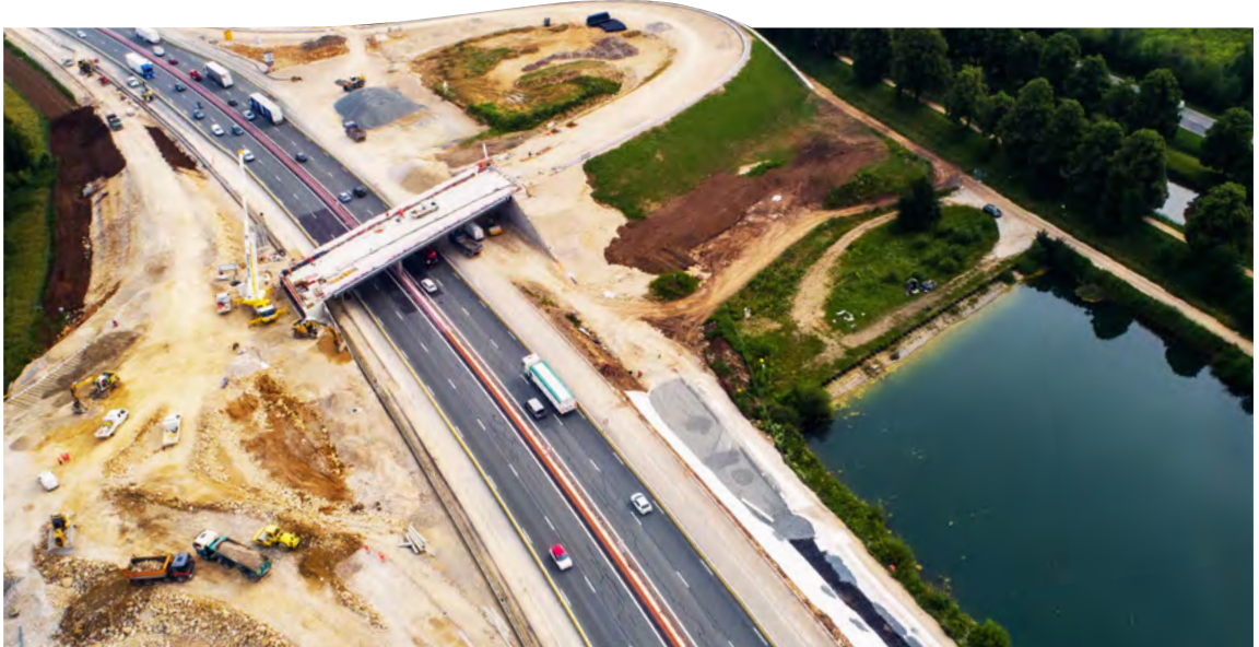
Remblai allégé pour le réaménagement de l'échangeur de l'autoroute A36 à FR-90400 Sevenans
