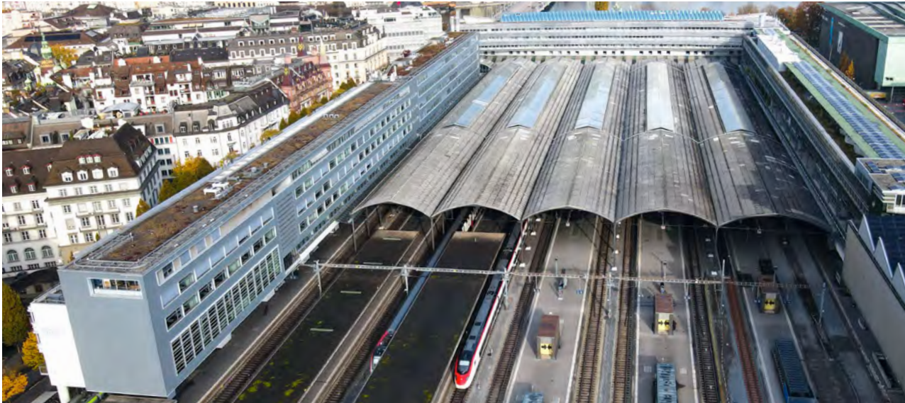
Tassement évité sur un sol fortement sollicité : Développé en collaboration avec les Chemins de fer fédéraux (CFF), gare à CH-6000 Lucerne
